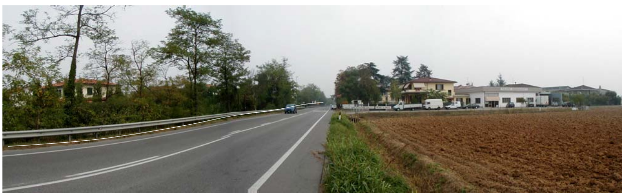
FOTO 2 – Il tratto alle porte della frazione di La Verza.
