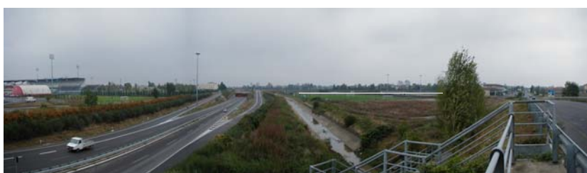
FOTO 8 - Il tratto terminale del rivo prima dell'immissione nel canale diversivo. Si possono notare lo stadio, la tangenziale, la strada statale Val Nure.
