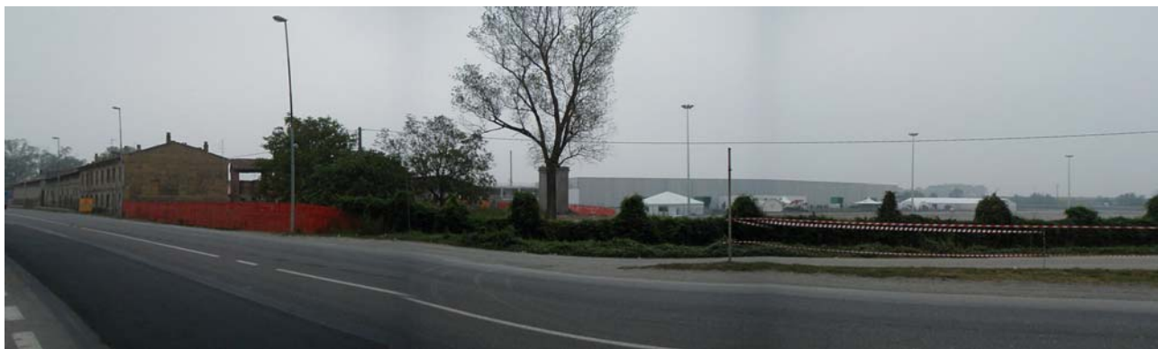
FOTO 4 – Il tracciato prosegue all'interno dell'area della nuova Fiera e Centro congressi. Sulla destra il cantiere della nuova Fiera.
