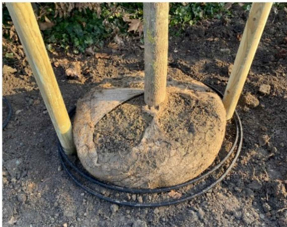
Inserimento di ala gocciolante interrata per l'irrigazione degli alberi
